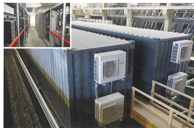
Holz Hahn entschied sich bei der Elektroinstallation für ein vorinstalliertes Plug-in-System mit einem klimatisierten Schaltschrankraum-Konzept in Containerbauweise
