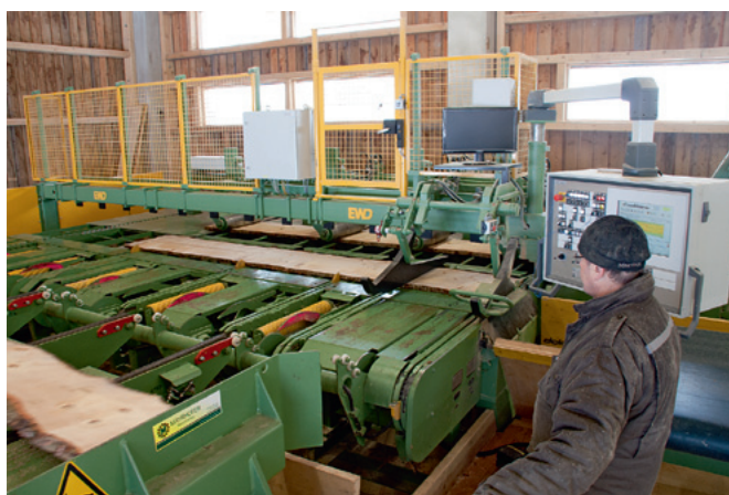
Einzugsbereich vor dem Combimes mit Brettwender, Kappung sowie Vermessung im Querdurchlauf
