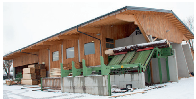
Die neue Halle, eine Kombination aus Holzfachwerk und Beton, beherbergt die neuen Sägewerksanlagen
