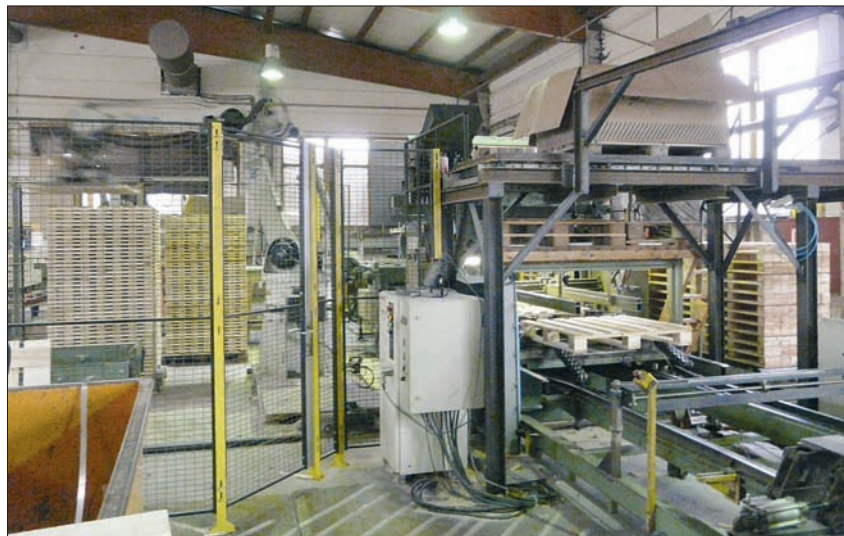
Palettenanlage mit Roboter-Beschickung von Komponenten
