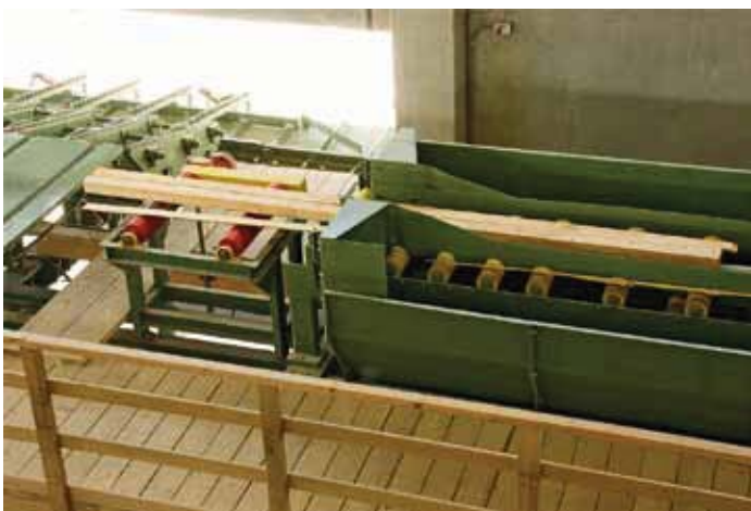
Hinter dem Besäumer ist ein Abscheider installiert, der die Spreißel automatisch ausschleust
