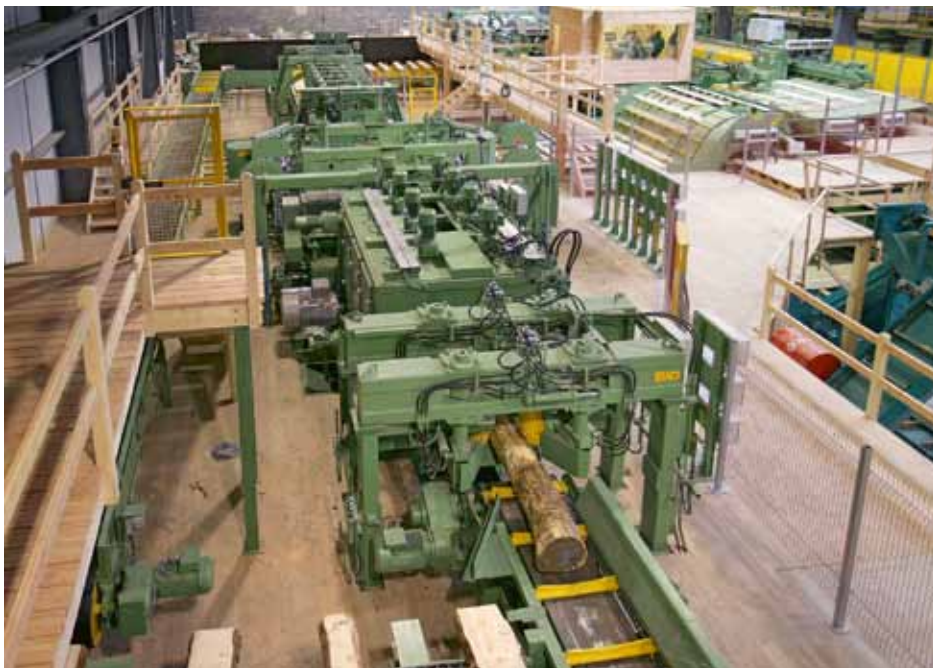
Bei Dubot in Saint Avit installierte EWD eine moderne Kreissägenanlage
