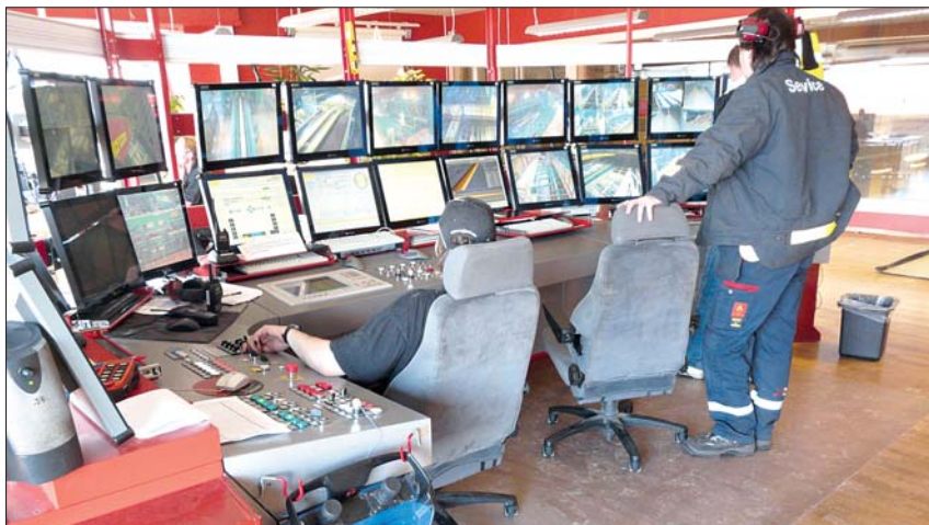
Im Leitstand der Linie – entspannte Arbeitsatmosphäre bei Tageslicht. Auch ein Besprechungstisch und der Pausenraum sind in den Raum integriert.
